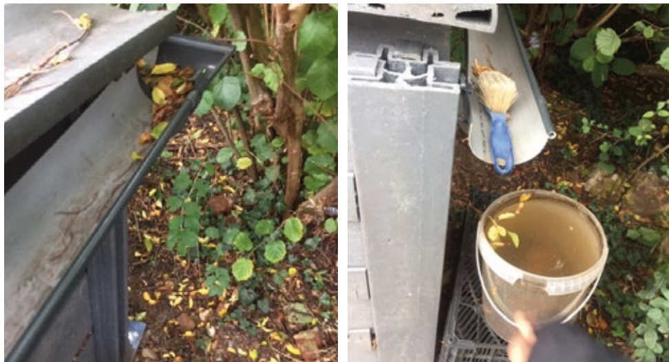
Récupération de l'eau au-dessus des compostières fermées
